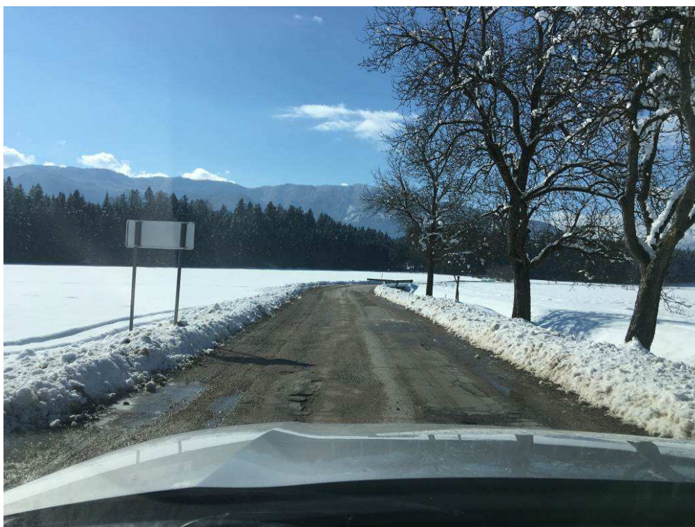
Slika 7: Pogled na traso
